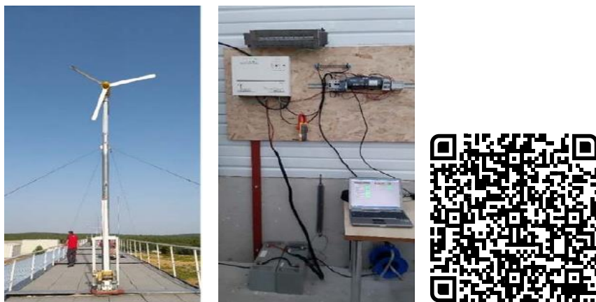
Figura 3.23. Instalación del aerogenerador y tablero de medición (Imágenes cedidas por CIEMAT).
