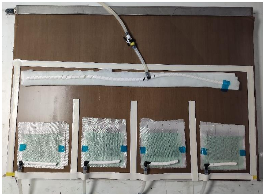
Figura 3.4. Colocación de tubos de entrada de resina y salida de aire.
